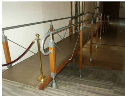
Fot. 6.5. Rampa dla niepełnosprawnych w Askeri Müze ve Kültür Sitesi Komutanlığı w Harbiye-Şişli koło Stambułu w Turcji (Źródło: zbiory autorów)
