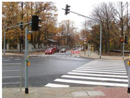
Fot. 6.44. Przejście dla pieszych z fakturowaną nawierzchnią i sygnalizacją świetlną (Źródło: zbiory autorów)
