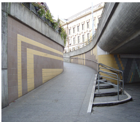
Fot. 6.6. Pochylnia w przejściu podziemnym w Konstancji, Niemcy (Źródło: zbiory autorów)
