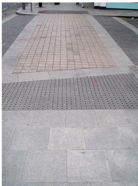
Fot. 6.46. Skrzyżowanie bocznej uliczki i chodnika w Dublinie – niwelacja różnicy poziomów z użyciem materiałów ułatwiających pieszym poruszanie się (Źródło: www.miejsca.org )
