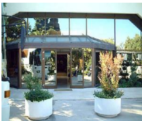
Fot. 6.2. Wejście do hotelu (drzwi automatyczne) Hotel Bon Repos – Wyspa Korčula, Chorwacja (Źródło: materiały reklamowe hotelu)
